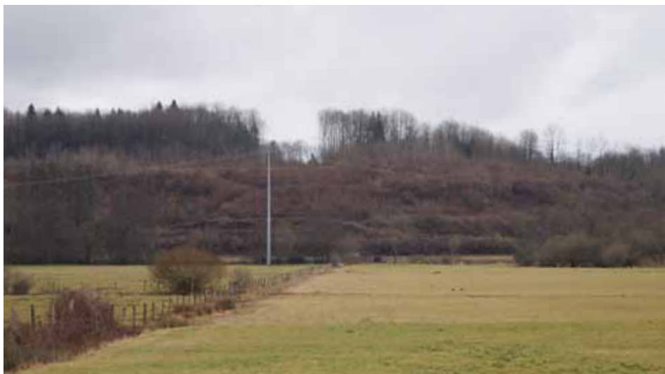
Ligne électrique à proximité du futur viaduc de la Saône
