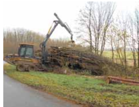
Travaux de déboisement
