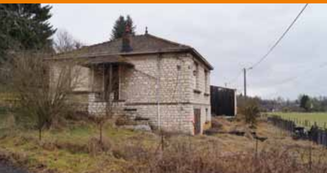
Maison à démolir (rue de Rémaucourt)
