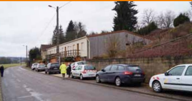
Maison à démolir (rue de Rémaucourt)
