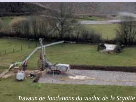
Maison située sous le futur viaduc de la Saône
