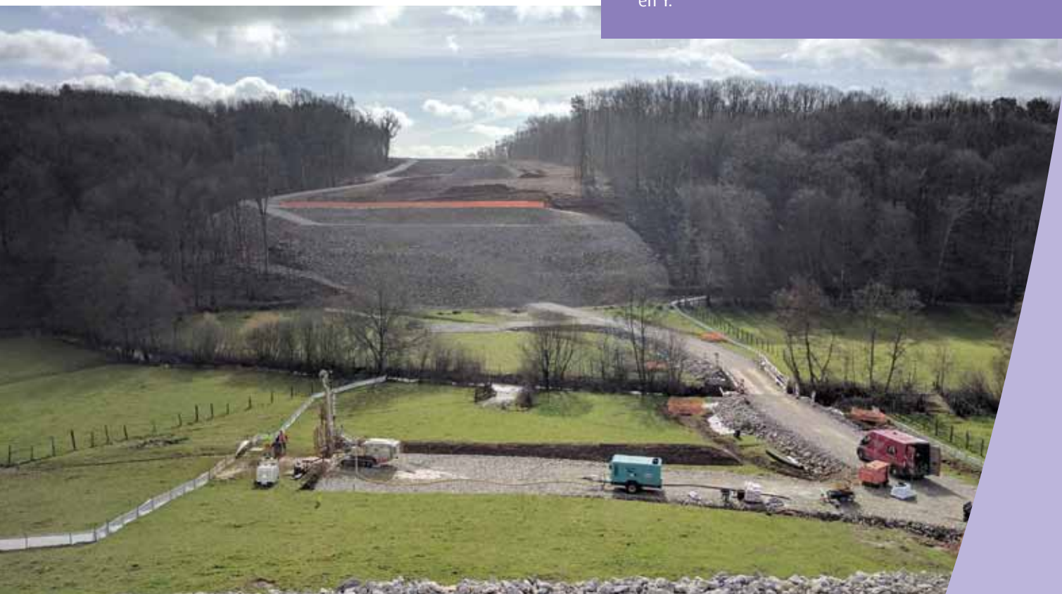
Travaux de fondations du viaduc de la Scyotte
