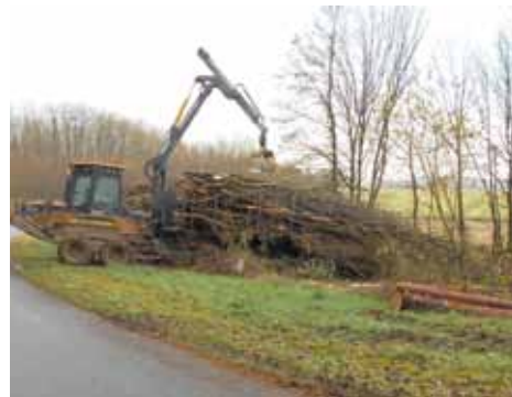
Travaux de déboisement
