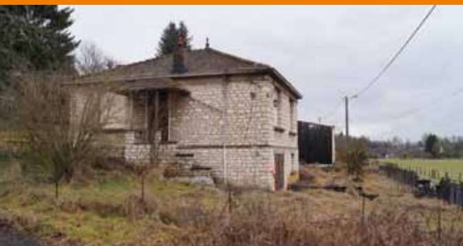
Maison à démolir (rue de Rémaucourt)
