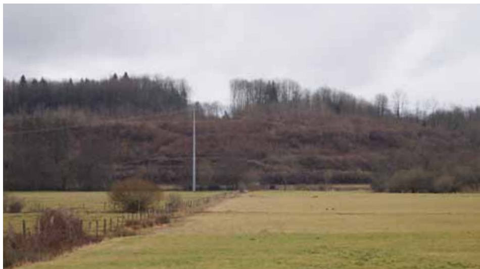
Ligne électrique à proximité du futur viaduc de la Saône
