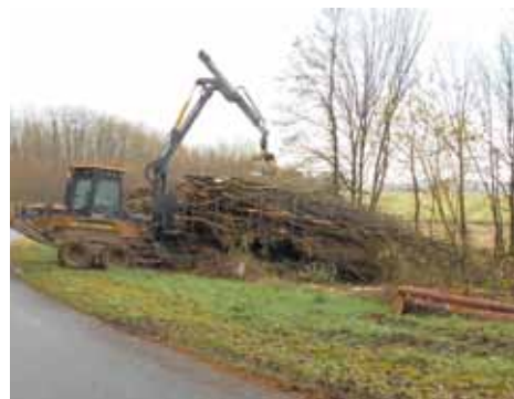
Travaux de déboisement
