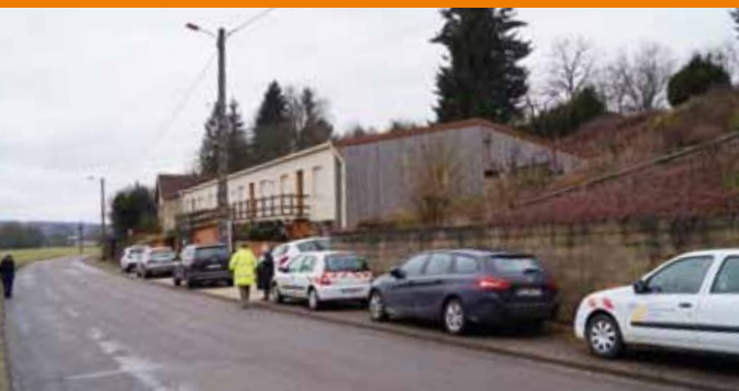
Maison à démolir (rue de Rémaucourt)
