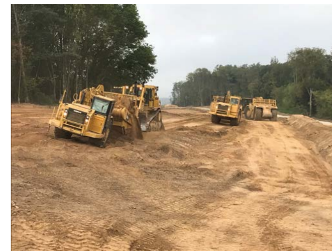
Scrapers et bulldozers en action près du futur échangeur de Port-sur-Saône
