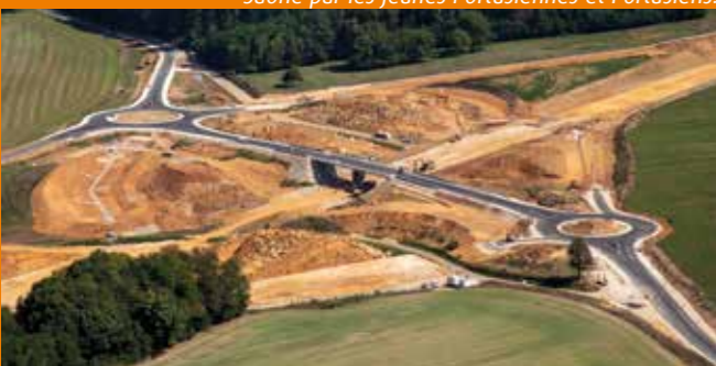
L'échangeur de Port-sur-Saône prend forme. La RD 6 est maintenant rétablie.
